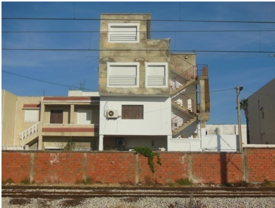
Le Kram, le long de la ligne TGM. Maison à R+1 à l'origine transformée en immeuble à R+3, les niveaux supérieurs étant desservis par un escalier extérieur. Exemple de « densification » destructive de tissu urbain Photographie numérique, Jellal Abdelkafi Juin 2014
