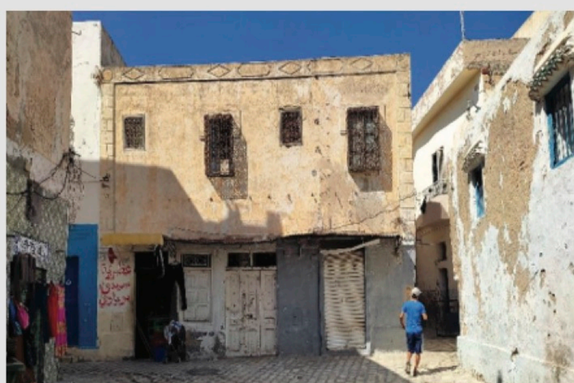
Photo d'un état actuel
